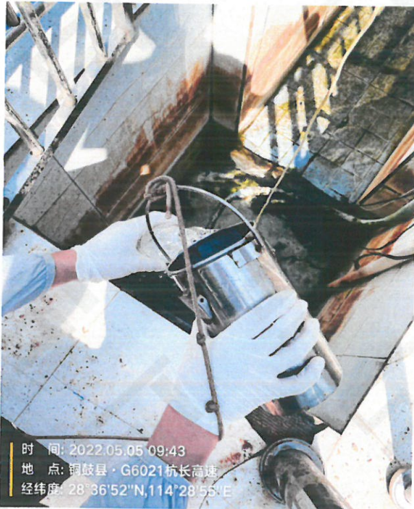
废水出口近景
