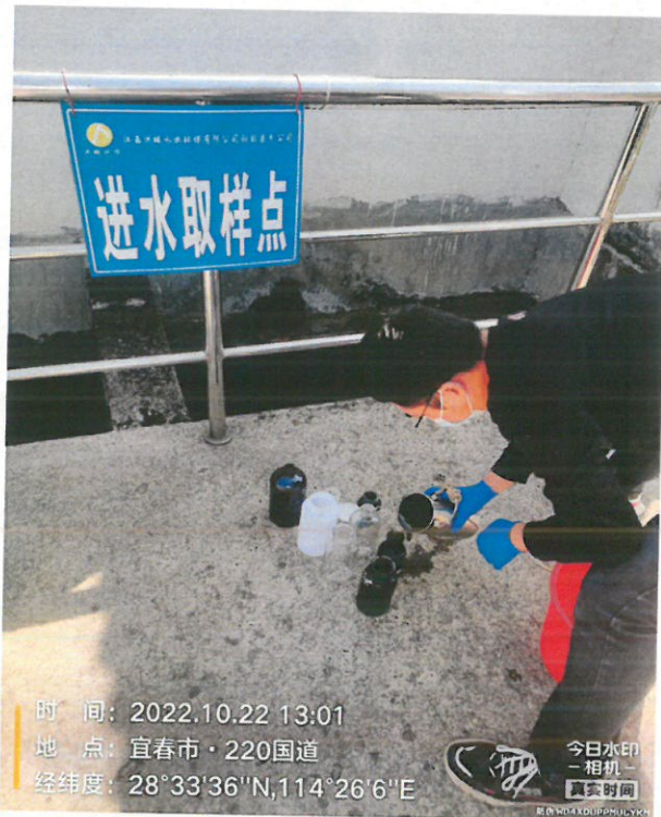
废水进口 (近景)
